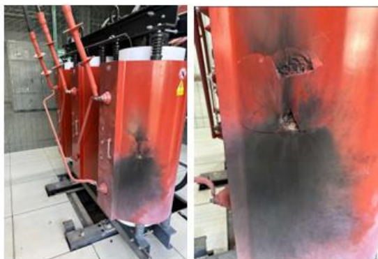
Figura 1 – Transformador Auxiliar TSA1 da Subestação Campinas avariado – 10/06/2023
